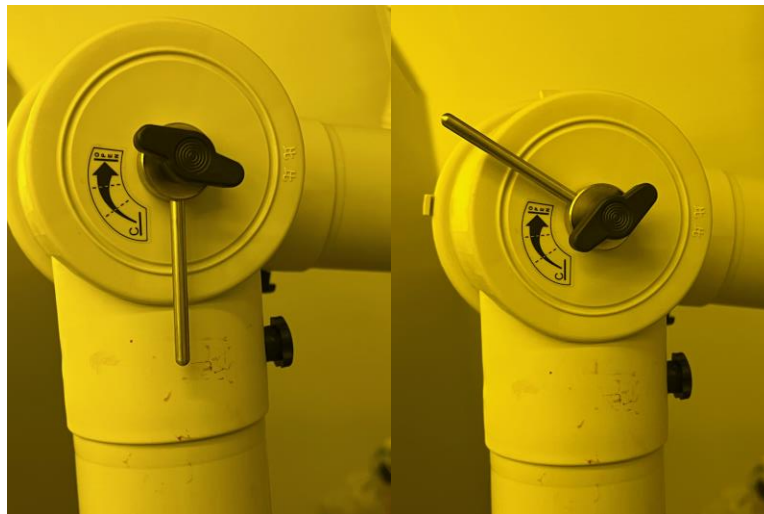
Figure 1 抽氣開關示意圖，左圖為關閉，右圖為開啟
